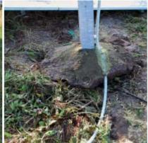
Sturmbilanz: Die Modulkonstruktion einer aufgeständerten Photovoltaikanlage wurde bei Windstärke 12 aus der Bodenverankerung gerissen. Die Solarmodule knickten ab, als seien sie aus Papier.
